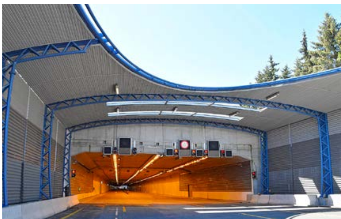
Die Tunnelbauwerke der A7 sind schlicht, robust und wartungsfrei, präsentieren sich zurückhaltend. So geht nachhaltig – auch beim Ausbau der Verkehrsinfrastruktur. © Ingenieurbüro GRASSL GmbH
