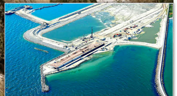
Tunneleinfahrt Puttgarden Fehmarnbelt-Tunnel Seite 19
